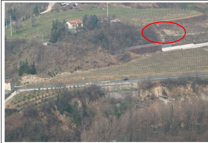
Fotogramma 4. Ubicazione del secondo sito di rilievo geomeccanico.
